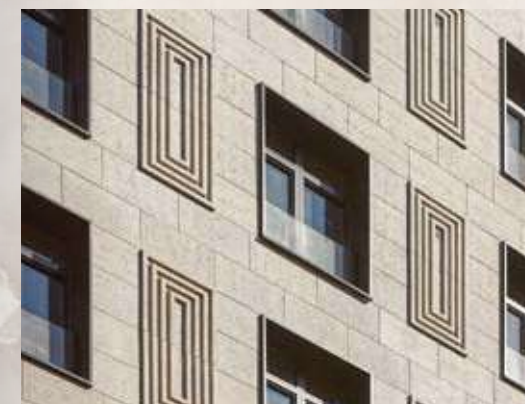
Дворовый фасад дома 1
